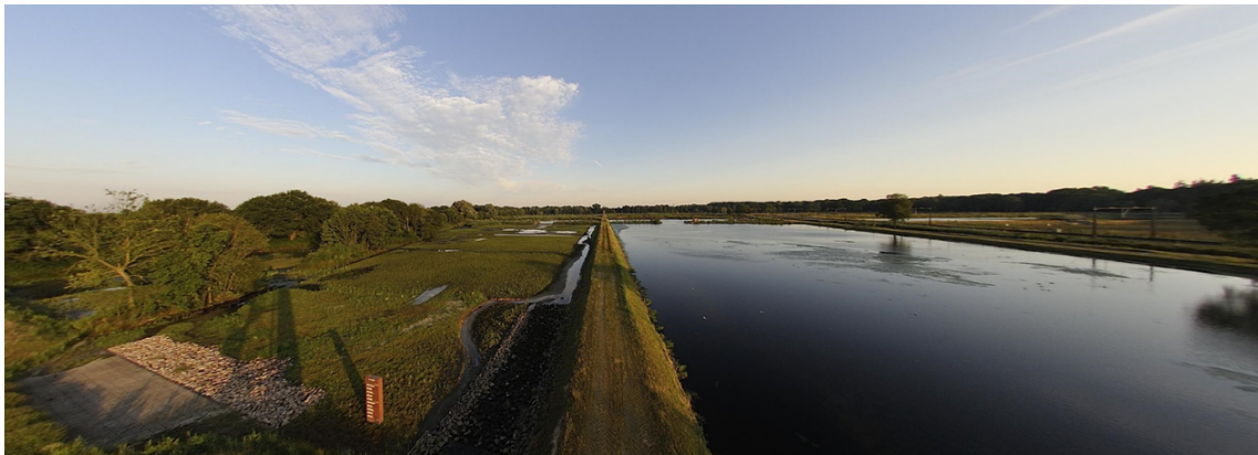
FIGUUR 2.2 HET EERSTE DEEL VAN DE WATERHARMONICA KRISTALBAD BESTAAT UIT DRIE PARALLELE, AFWISSELEND GEVOEDE/GELEEGDE VIJVERS): LINKS OP DE FOTO VLAK VOOR HET VULLEN EN DE RECHTS NA HET VULLEN). (FOTO RUUD KAMPF)
