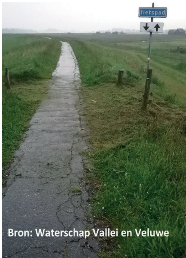
TOESTAND VAN ASFALT KAN GOED BEOORDEELD WORDEN
