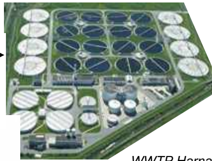
WWTP Harnaschpolder - Delft
