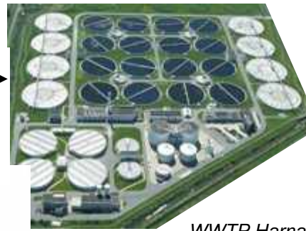
WWTP Harnaschpolder - Delft
