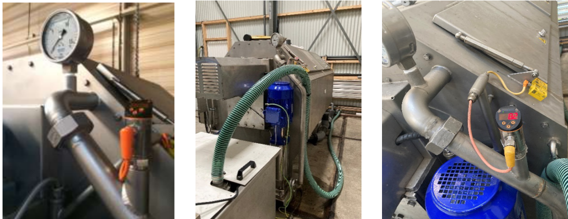
FIGUUR 0.50 DRUKBEWAKING SPROEIERS MET DRUKSENSOR
